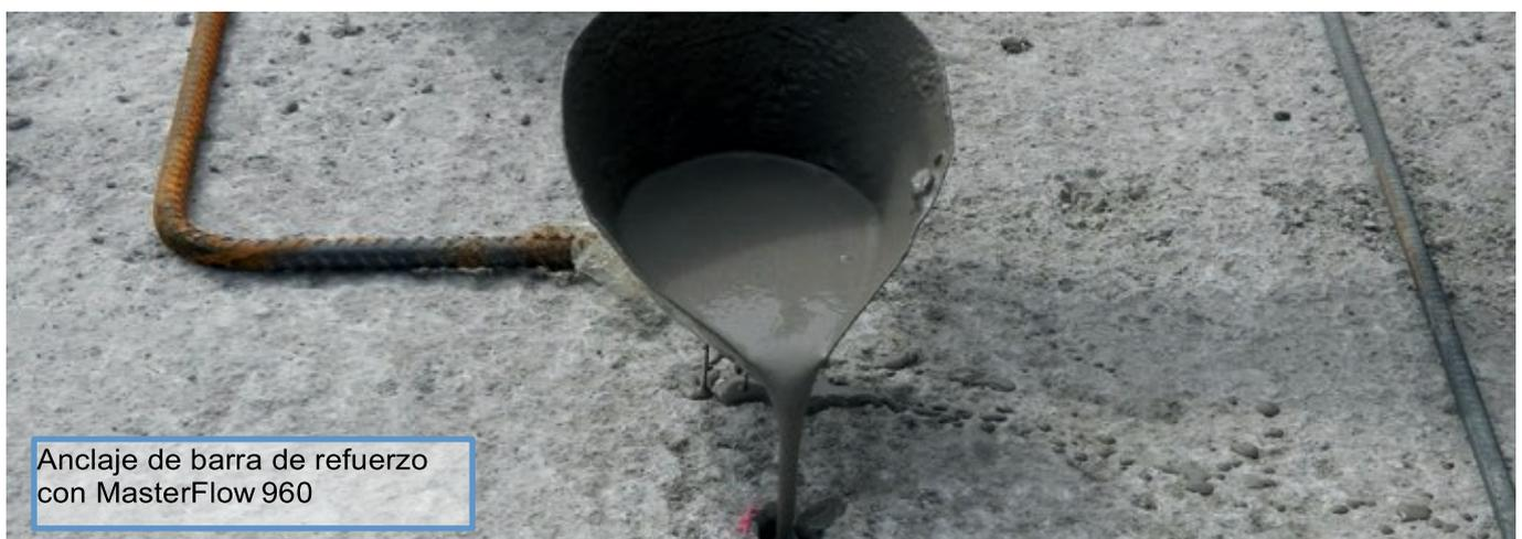
Anclaje de barra de refuerzo con MasterFlow 960
