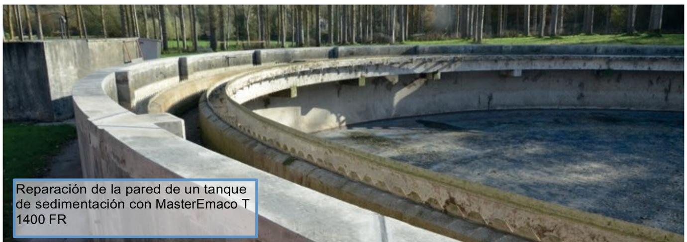
Reparación de la pared de un tanque de sedimentación con MasterEmaco T 1400 FR
