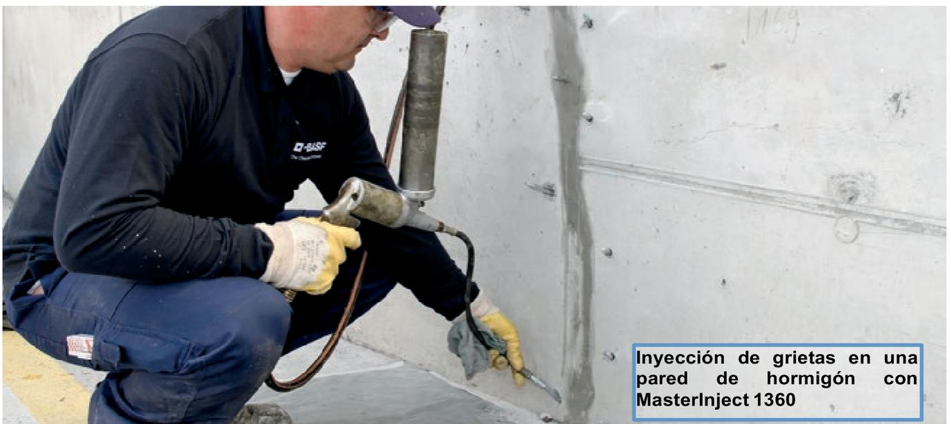
Inyección de grietas en una pared de hormigón con MasterInject 1360
