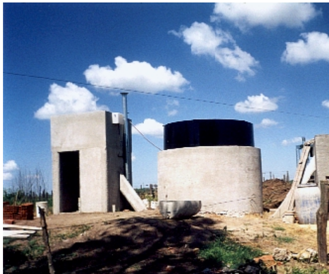
Figura N° 1 - Digestor con campana tipo Hindú, construido en la Escuela Inchausti, durante la ejecución del Proyecto.
